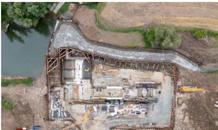
Aktuálny pohľad na stavebné práce. Zmizol 85 rokov starý jez Sudoměřice. Nová konštrukcia zaistí bezpečnú plavebnú hladinu Baťovho kanála.
